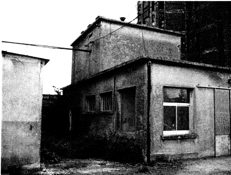
Vue du bâtiment des transformateurs coté est
