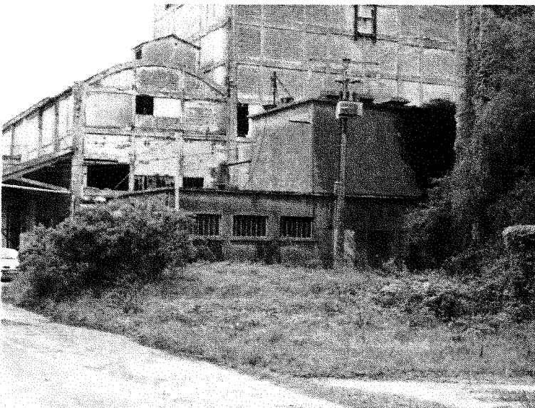
Vue du bâtiment des transformateurs coté nord
