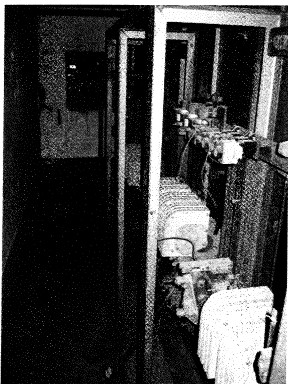
Local électrique – coté gauche – arrière des tableaux de commande
